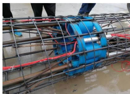
图 2 荷载箱安装
