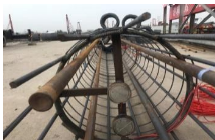
图 1 土压力计安装
