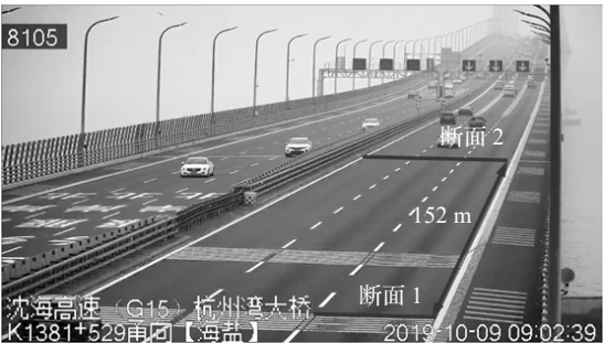
图 1 杭州湾跨海大桥交通流场景示意图
