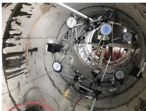
图 7 主隧道破洞阶段
