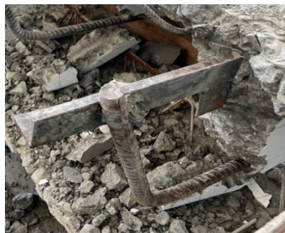
图 7 角钢内部细化图
