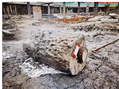
图3 同步同心旋喷式复合斜撑桩现场开挖照片
