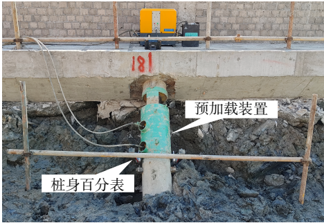
图 4 斜撑桩静载试验装置
