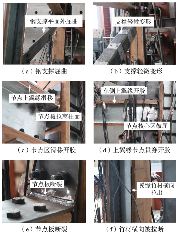
图 8 支撑试件相应受损情况
