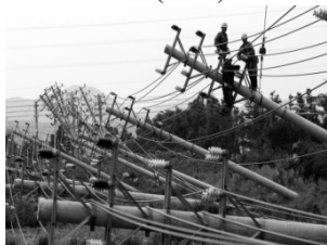
电线杆倒塌
