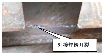
图 4 BASE 试件的破坏照片
