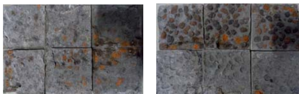
(a) 人工凿毛处理 (b) 露骨料水洗剂处理
