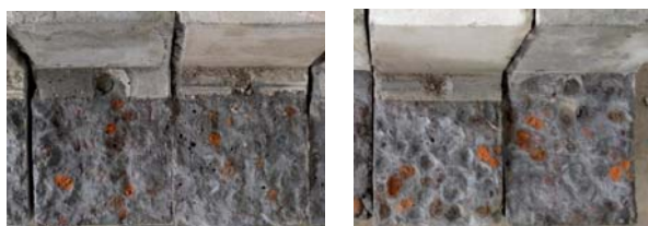
(a) 人工凿毛处理 (b) 露骨料水洗剂处理
