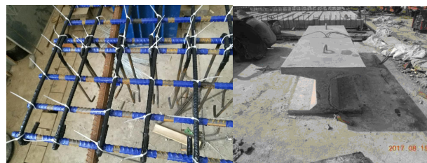
(a)梁底纵向钢筋绝缘和绑扎 (b)浇筑完成后拆模
