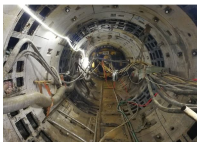
图 2 机械法联络通道施工
