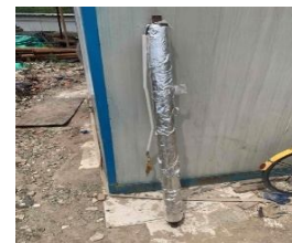
(d)保温处理之后的无缝钢管
